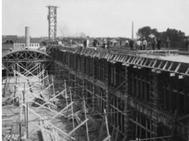
Figuur 38 De Wiebengehal in aanbouw, 1912. Foto: Collectie Sociaal Historisch Centrum Limburg. Het Wiebengacomplex, kort na oplevering in 1912. Foto: Jan Gerko Wiebenga.
