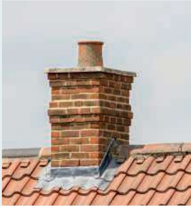
figuur 7 De aansluiting tussen schoorsteen en dak is afgedicht met een loodslab.
