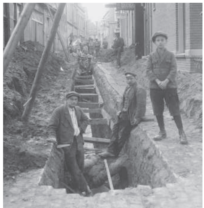
Bron 1 Bouwvakkers leggen in de stad Groningen een nieuwe riolering aan, zodat alle woningen een eigen wc kunnen krijgen. (Foto uit 1926.)
