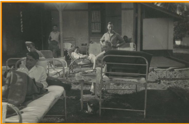
Foto tussen 1945 en '50 bij de derde hulp verbandplaats in Nederlands-Indië. 'Bij de schoonmaak van het hospitaal moesten de bedden er uit. Tjiandjoer'-(kamp)
