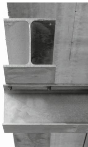
▲ figuur 9 stalen balken met een H-profiel
